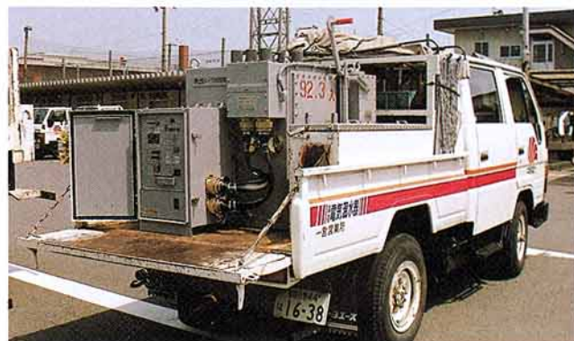
第4図 作業車積載状態
