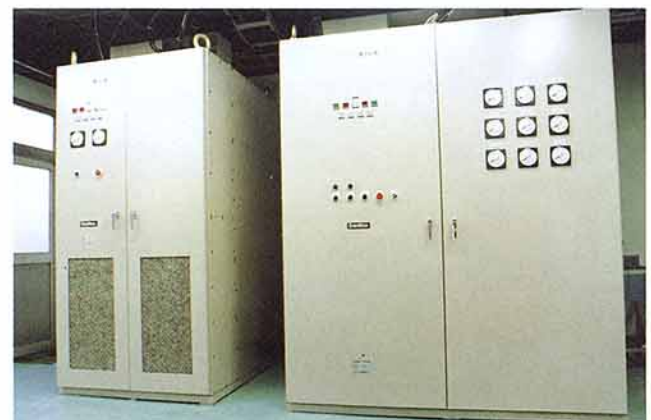
直流プラズマ電源装置 単相・交流切替式交流電源装置
