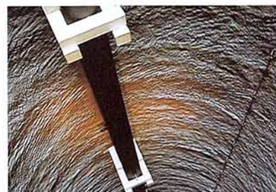
第4図 スタック内部の状況
