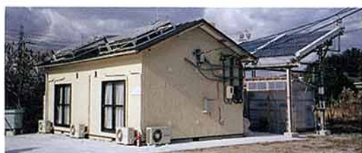
第1図 ソーラ実験棟全景
