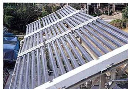
第4図 真空管式太陽集熱器
