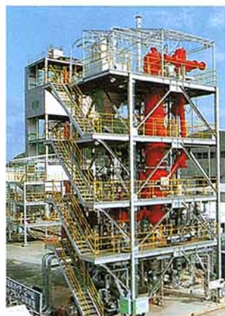
加圧流動床ボイラのパイロットプラント
