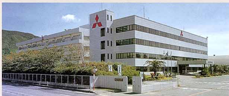
長崎研究所本館(右)と基礎技術実験棟(左)
