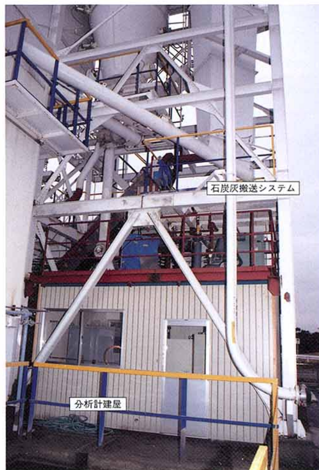
第1図 試験装置設置箇所
