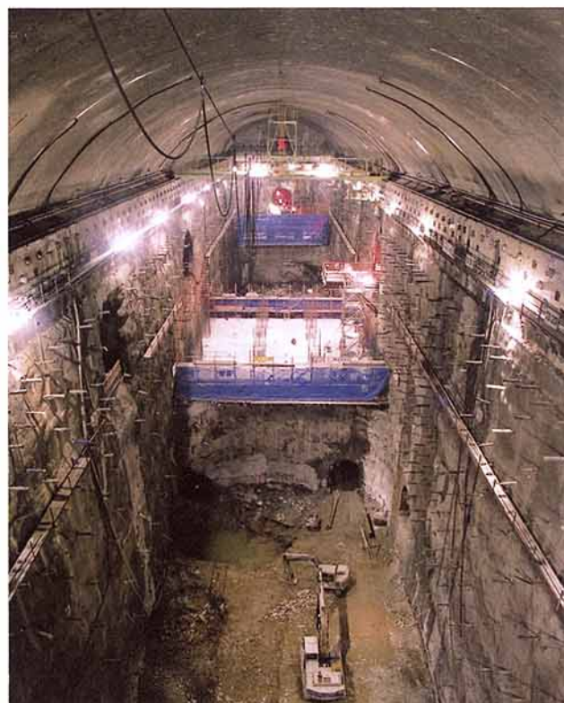
第1図 地下発電所掘削状況 (1～4号機地下空洞)
