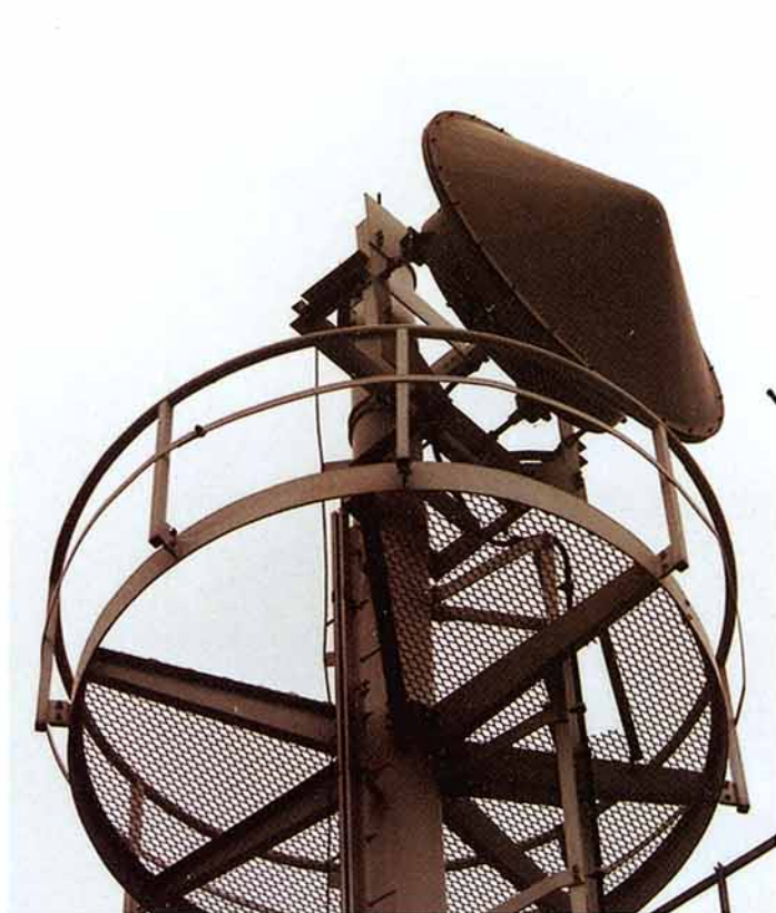
第1図 無線鉄塔(鉄柱型)
