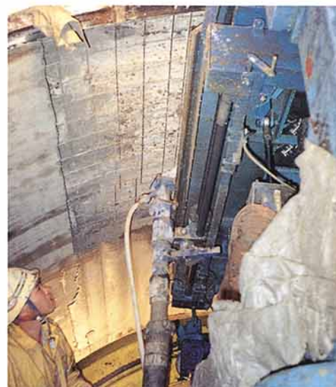
第4図 コンクリート打設状況
