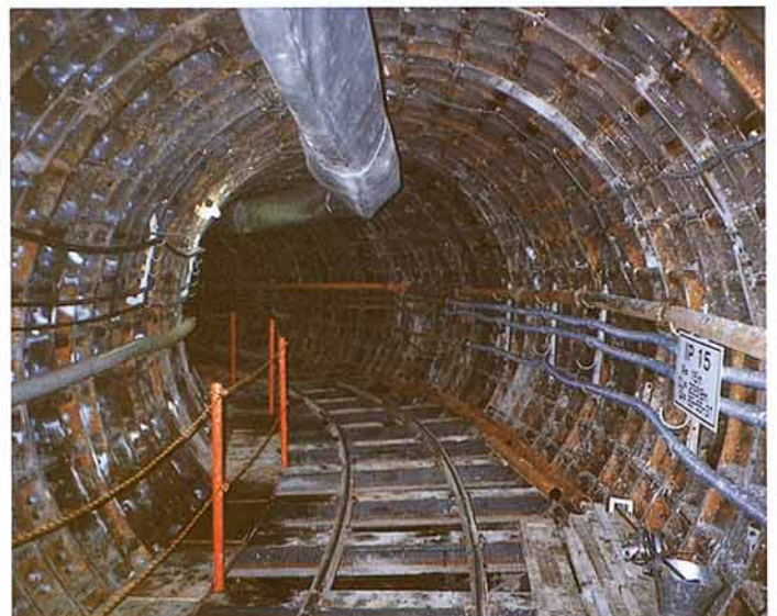
超急曲線施工完了状況
