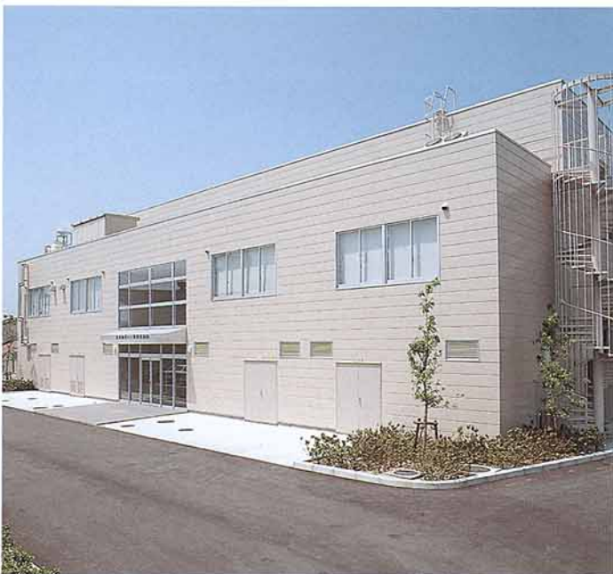
第1図 エネルギー・環境実験棟の外観
