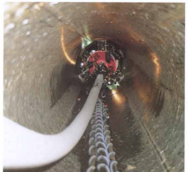
第5図 作業後の配管内面状態
