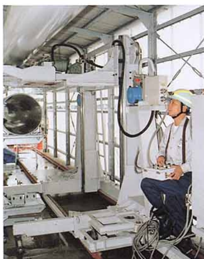
第4図 接合用据付作業台車
