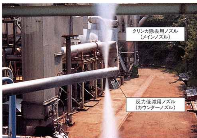
第4図 蒸気噴射状況(試験炉横で大気へ噴射)
