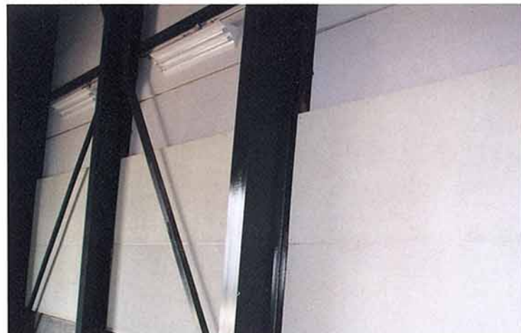
第4図 実験棟への施工例
