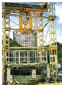
第2図 鉄筋かご沈設工法
