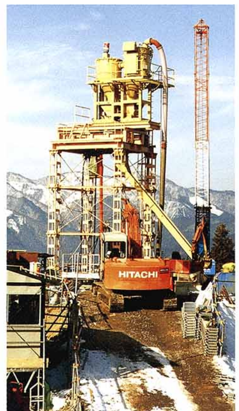
第3図 実証施工全景
