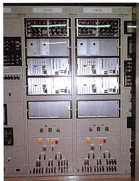
第4図 保護装置の外観 (地下親局)
