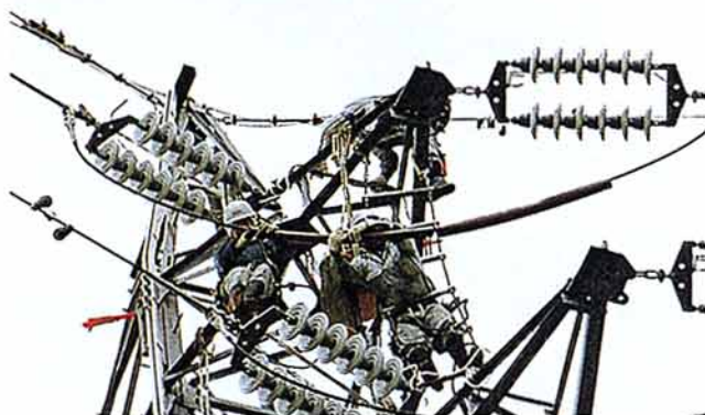
第3図 現場取付状況
