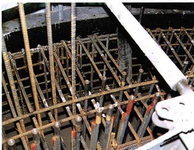
第4図 高流動コンクリート打設状況
