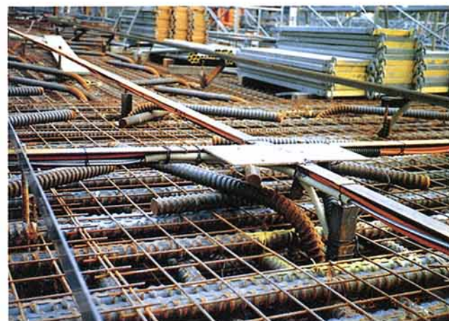
第3図 光ファイバセンサ敷設状況 (鋼材裏のオレンジ色のケーブル)
