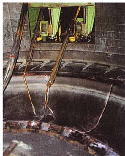
第2図 現地肉盛溶接状況
