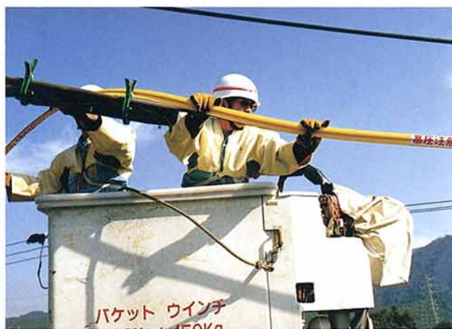
第1図 従来の作業風景(直接活線作業)
