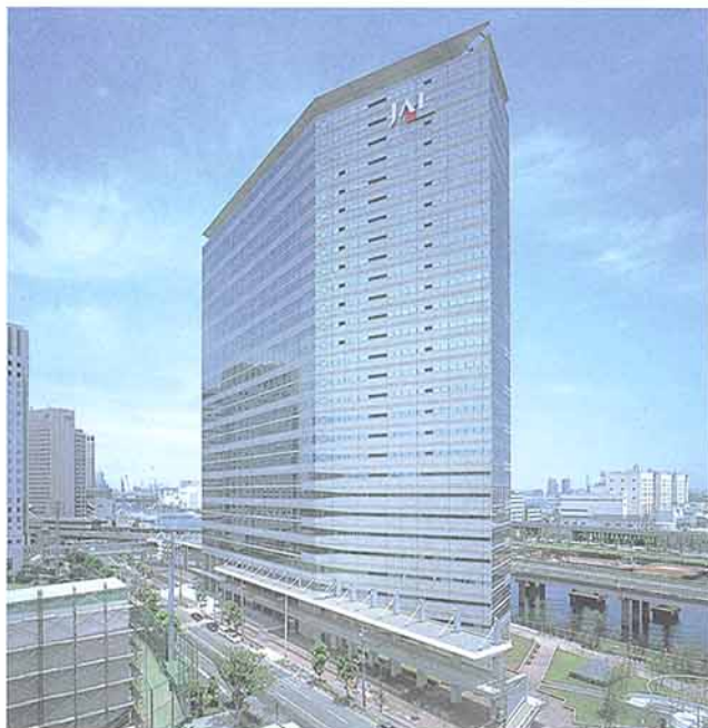
制震装置を組込んだJAL本社ビル
