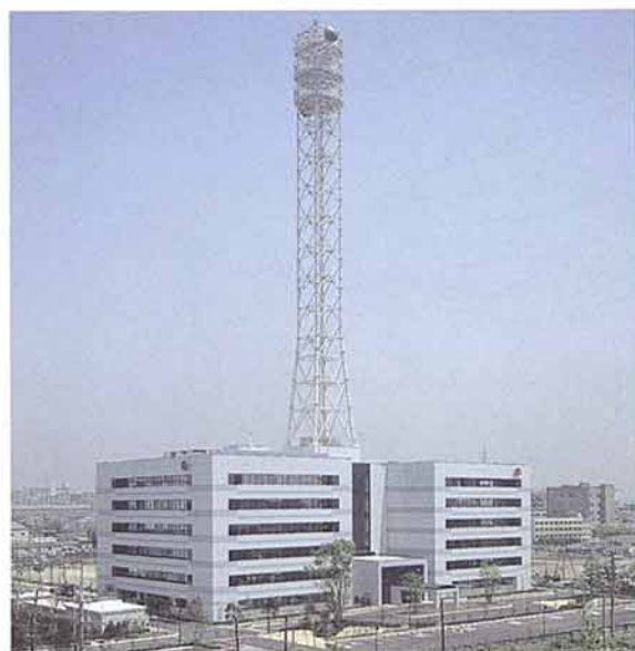
第1図 火力センタービル全景
