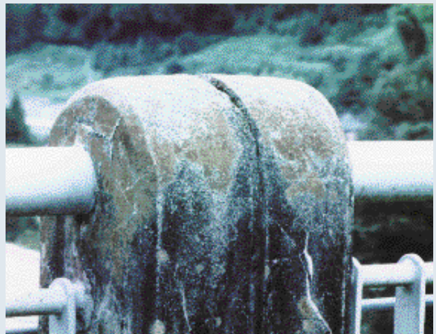
第1図 汚れが顕著に見られるコンクリート構造物
