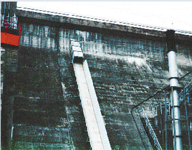
第1図 汚れが顕著に見られるコンクリート構造物
