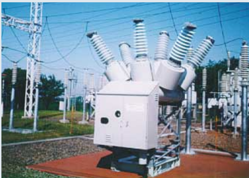
第1図 フィールド試験状況
