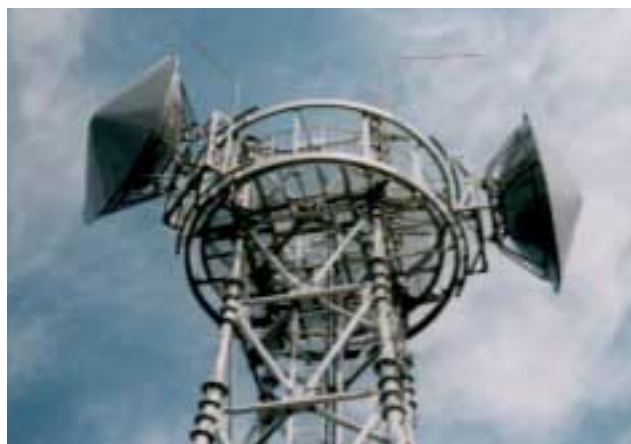
第2図 傾斜型避雷針
