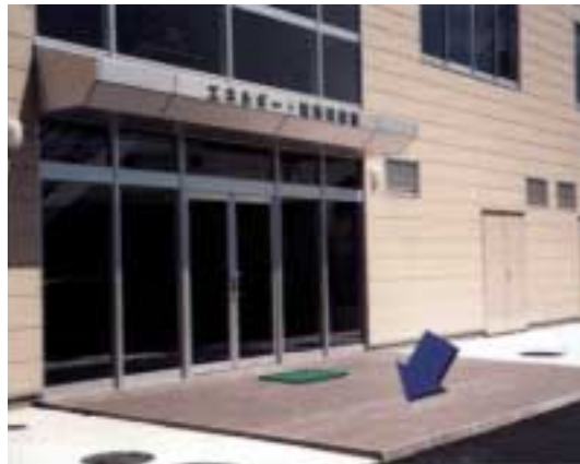
電力技術研究所 エネルギー・環境実験棟
