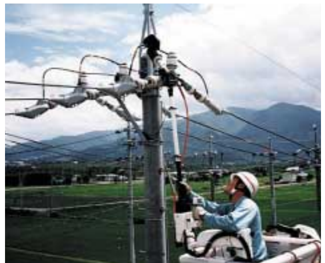
第2図 開発品とスーパーアームによる電線接続作業
