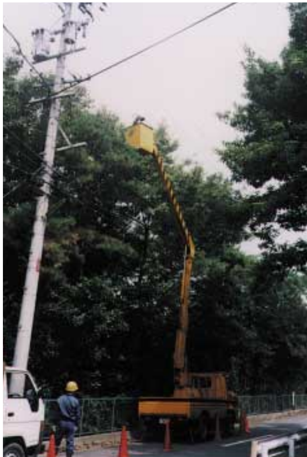
第1図 配電伐採の現場
