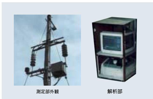
第1図 がいし塩分付着量自動測定装置
