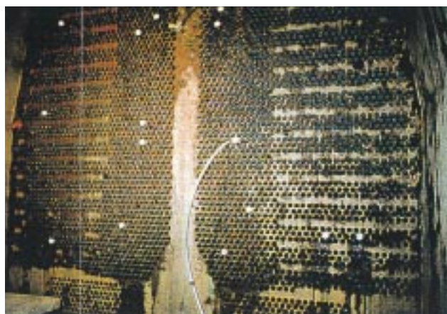
第3図 プローブを用いた復水器細管の測定状況
