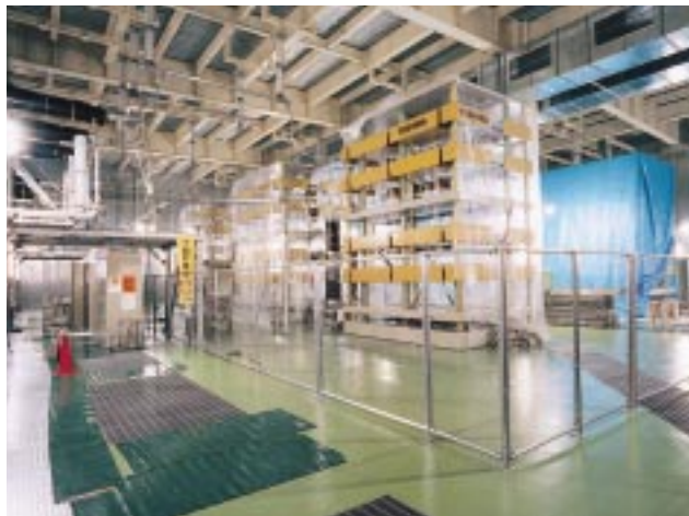
第1図 交流 直流変換装置(サイリスタバルブ)
