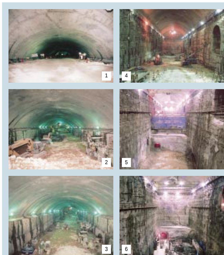
写真2 中部電力(株)奥美濃地下発電所空洞掘削の進展状況。工事の安全確保のため、側壁部に掘削されたボーリング孔内でAE測定が行われた。
