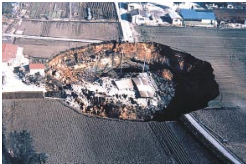
写真1 大谷石採掘跡の崩落事故（栃木県宇都宮市）。この崩落の後、2次崩落の予知のためAE測定が実施された。
