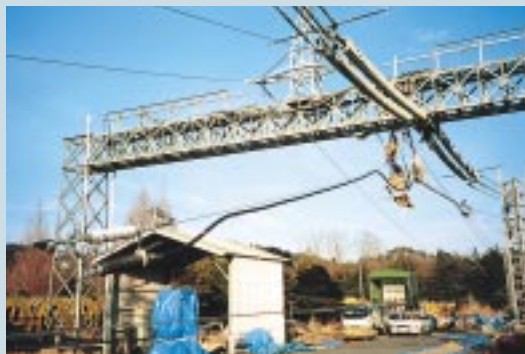
(a) ケーブルジャンパ線全体
