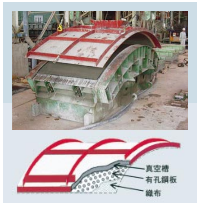
第4図 真空脱水型枠法
