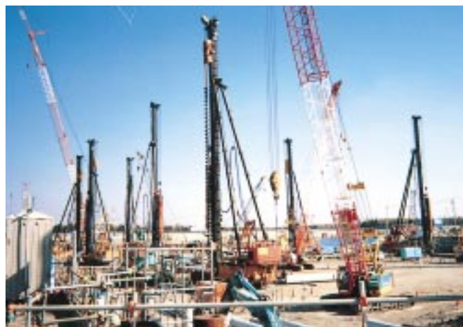
第5図 既製コンクリート杭打設状況（碧南火力発電所増設工事）
