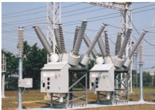
第1図 フィールド試験状況
