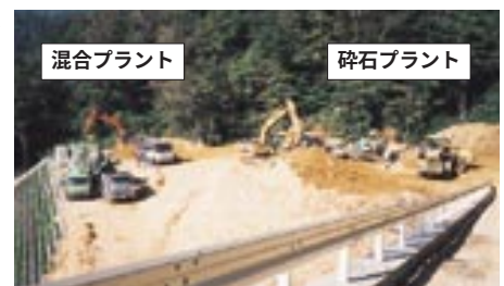
写真-1 混合プラントと砕石プラントの設置状況
