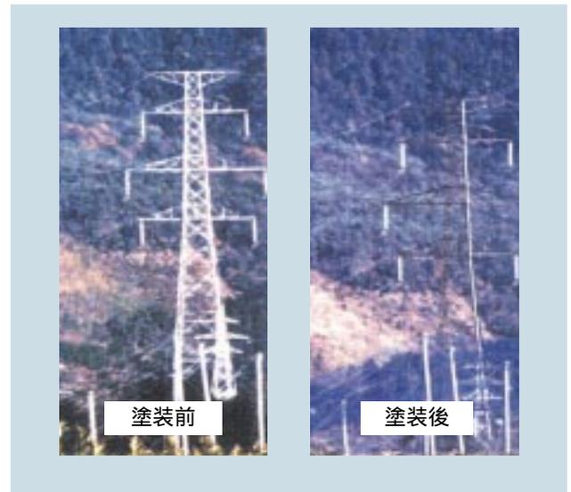
第3図 最適色彩による鉄塔塗装状況例
