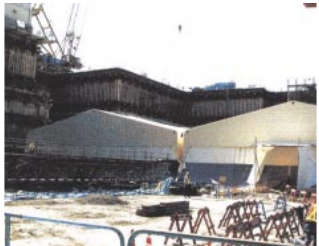
第5図 岩盤養生テント
