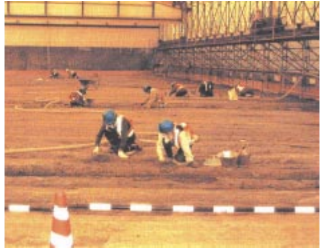
第4図 岩盤清掃状況
