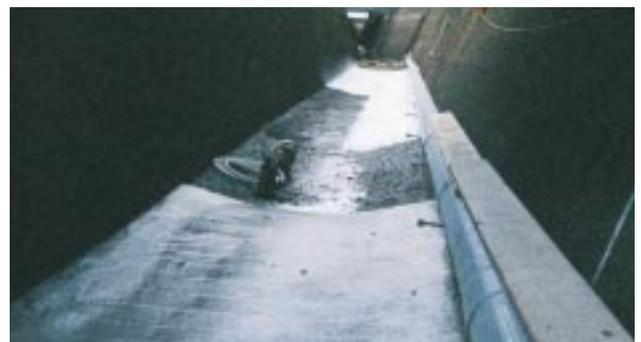
菊水化学工業殿と共同開発中の廃碍子利用の水路補修モルタル (試験施工時の状況)
