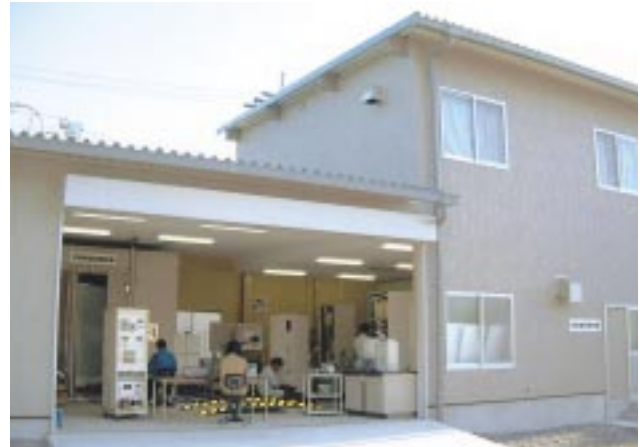
第1図 実験棟外観
