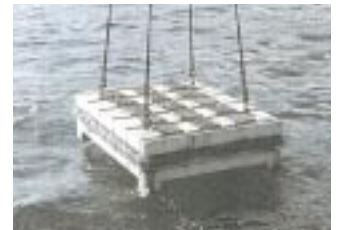
藻場造成コンクリート基盤の海域布設状況
