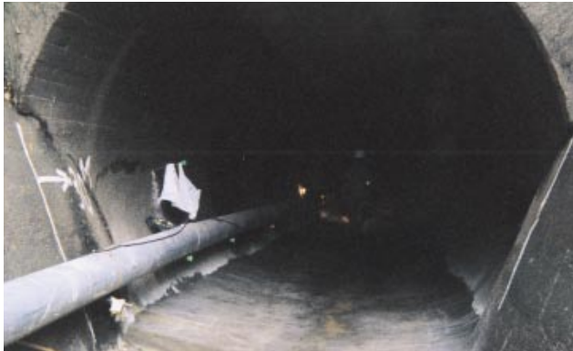
第11図 碓子くずを利用した水路床面補修工事
