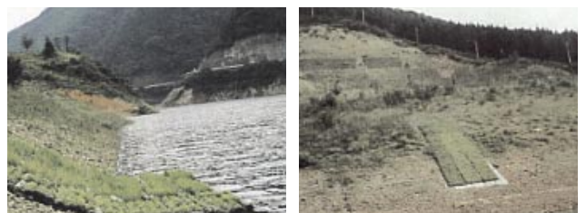
第19・20図 調整池の法面に設置した片浮型緑化床
