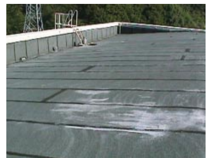
第9図 アスファルト屋根防水
