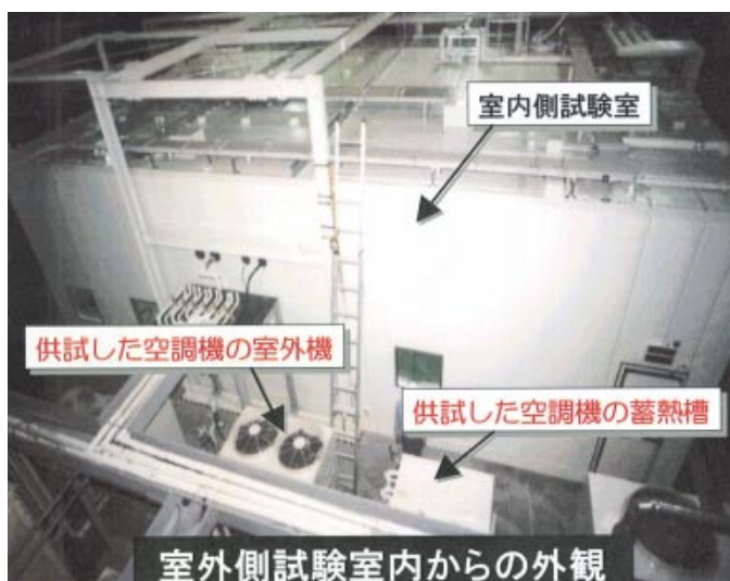
第2図 大型空調試験装置の外観
