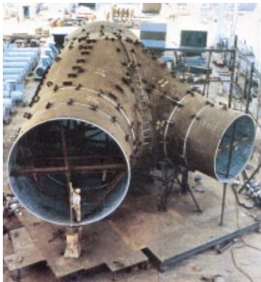
写真1 奥矢作第一発電所水圧鉄管エッシャーウィス型分岐管
