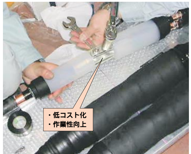
第2図 羽子板端子方式の採用
