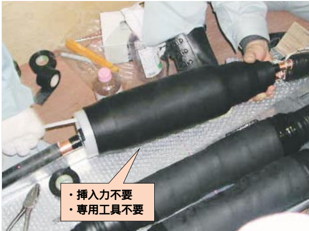
第3図 常温収縮方式の採用
