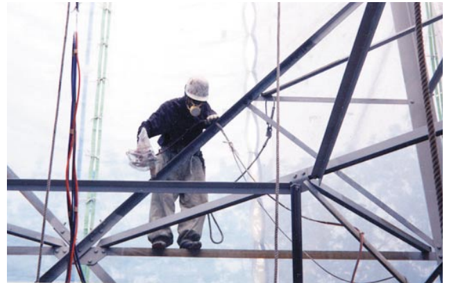
第5図 高塗着スプレー工法施工状況
