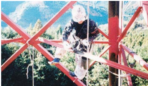
第1図 刷毛塗り施工状況
